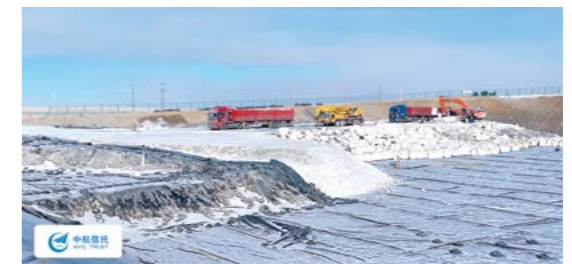
危废处置项目现场
